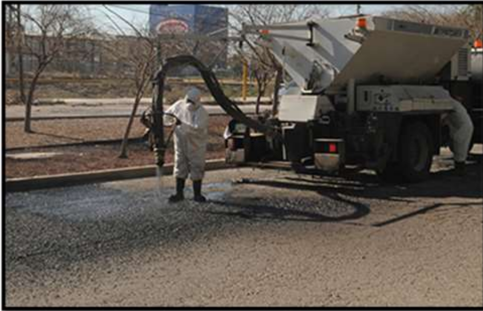
Fig. Plano Informativo. Bacheo con equipo Jetpatcher sobre la calle de Espinoza y Cuevas en la colonia Julián Carrillo . S.L.P. 12, marzo, 2014
