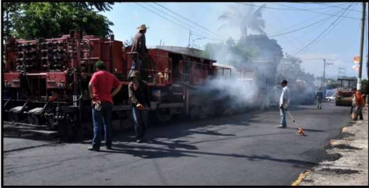
Fig. Plano Informativo, Rehabilitación de pavimento asfáltico con la maquina Dragón de asfalto o Dragón rojo. Recuperadode: http://notiastro2002.blogspot.mx/2011_10_01_archive.html .
