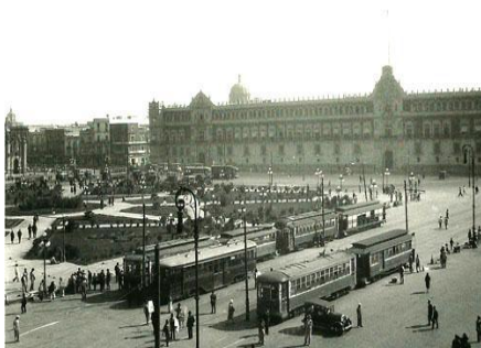
Fotografía 3. Zócalo en 1930. Faroles Tipo Arco Metálico con electrodos de carbón
