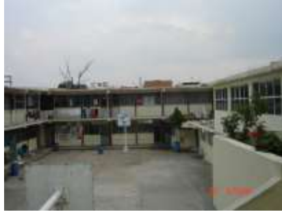
Detalle del interior de la escuela
