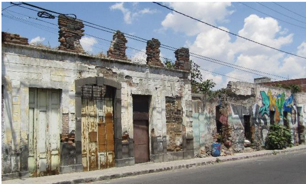
Figura 9. El paisaje deteriorado de los barrios obreros de principios del siglo XX. Avenida 26 poniente y calle 5 sur. Imágenes: JECL, 2018.
