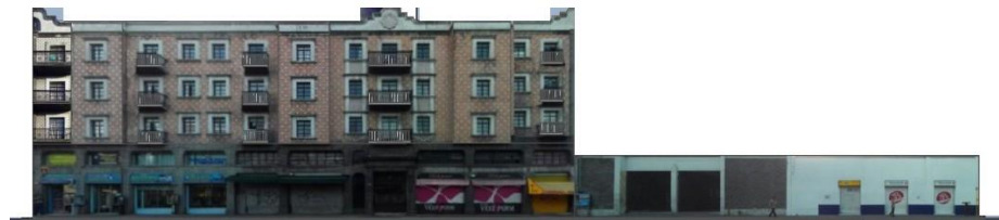
Fig.4. Costado Poniente (11 Sur)
