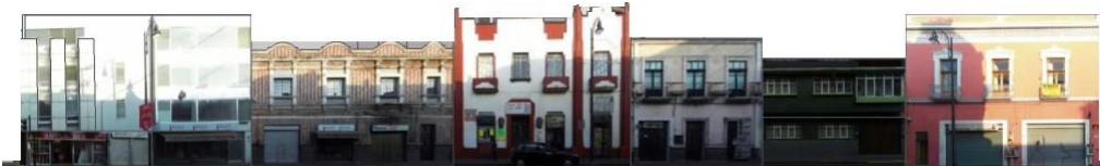
Fig. 3. Costado Oriente (9 Sur)
