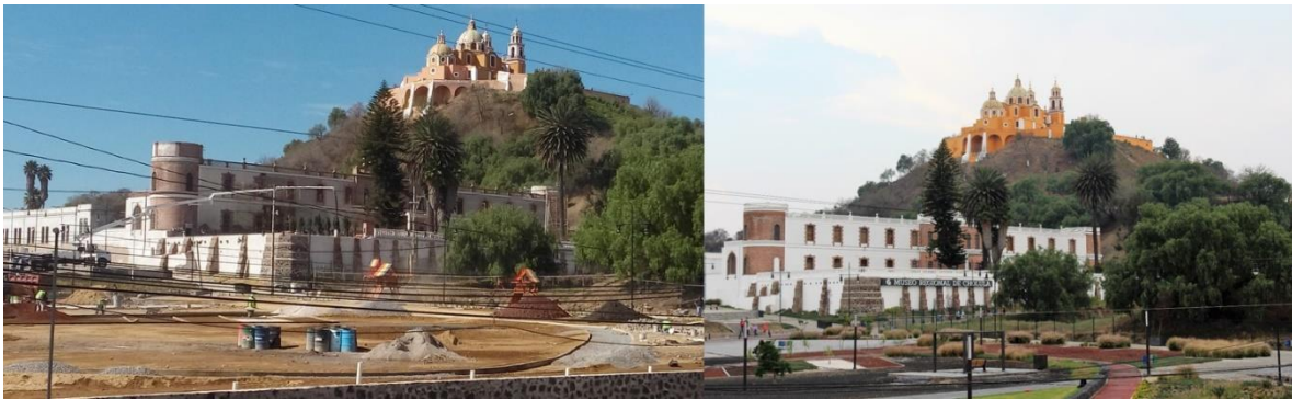
Figura 2. Vista norte de las obras del parque y remodelación del antiguo hospital psiquiátrico en proceso (izquierda). Habilitación del parque y Museo Regional de Cholula inaugurado (derecha).
