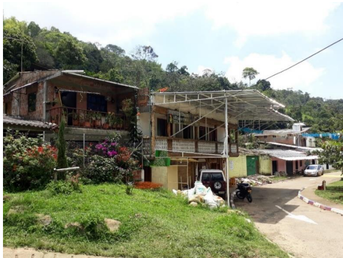
Figura 2. Podemos apreciar los elementos constructivos que conforman el paisaje urbano del corregimiento. En un ordenamiento de autoconstrucción
