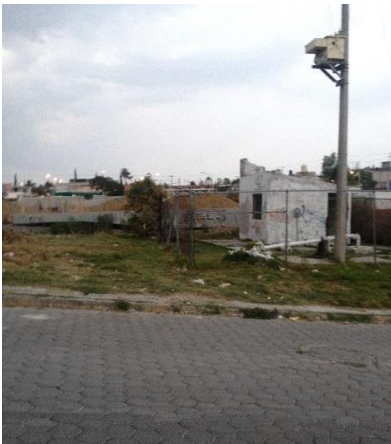
Figura 2 Espacio público en mal estado. Elaboración propia
