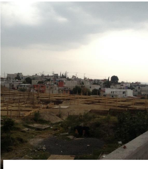
Figura 4 Construcción de casa de cultura. Elaboración propia
