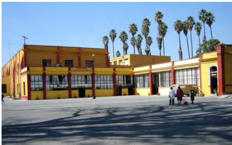
Figura 1. Ala derecha del edificio, fue sede del Área de Lenguas extranjeras. Hoy es del H. Consejo Universitario. Rre.2007.
