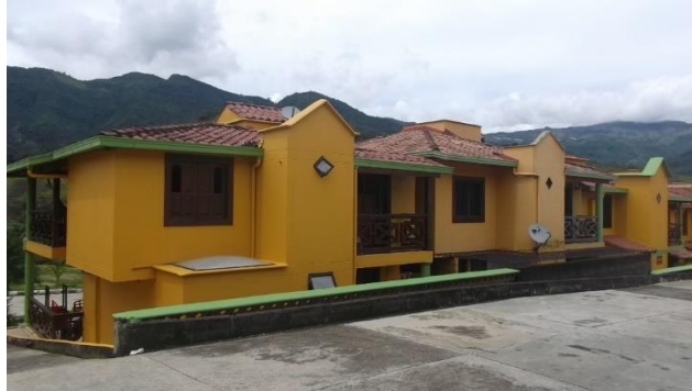
Figura 20. Otro ejemplo es el conjunto residencial, llegando a la ciudad de Andes desde Medellín, que recupera el elemento de diseño campesino adaptándolo a la construcción moderna y funcional. de la llamada casa campesina, con espacios abiertos, ventanas de madera sin cristales y teja.
