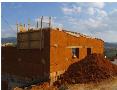
Figura 6. Construcción de vivienda en tapia pisada, Barichara, Santander
