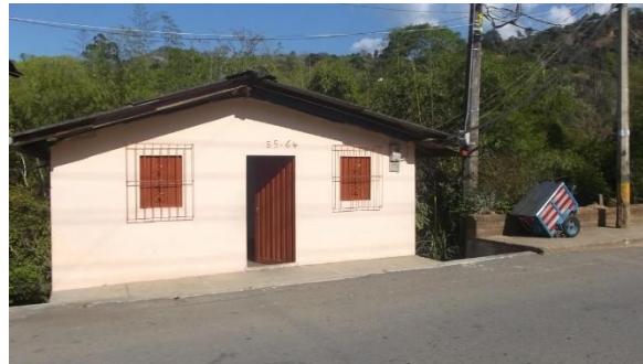
Figura 16. Construcción emergente. No contiene los elementos mínimos de la vivienda tradicional, aquí podemos apreciar el cambio de uso de materiales más modernos, con un diseño simple.
