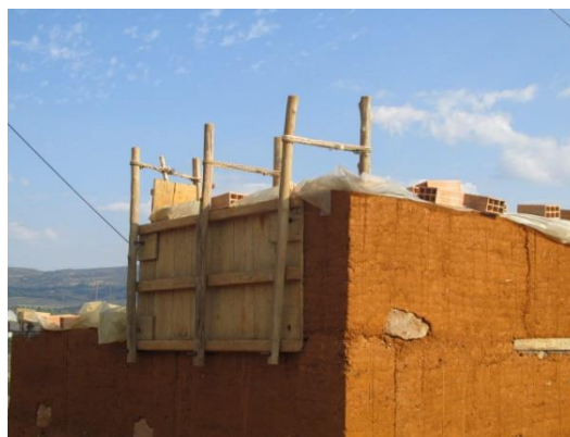
Figura 7. Detalle del tapial en la construcción de vivienda en tapias pisada, Barichara - Santander
