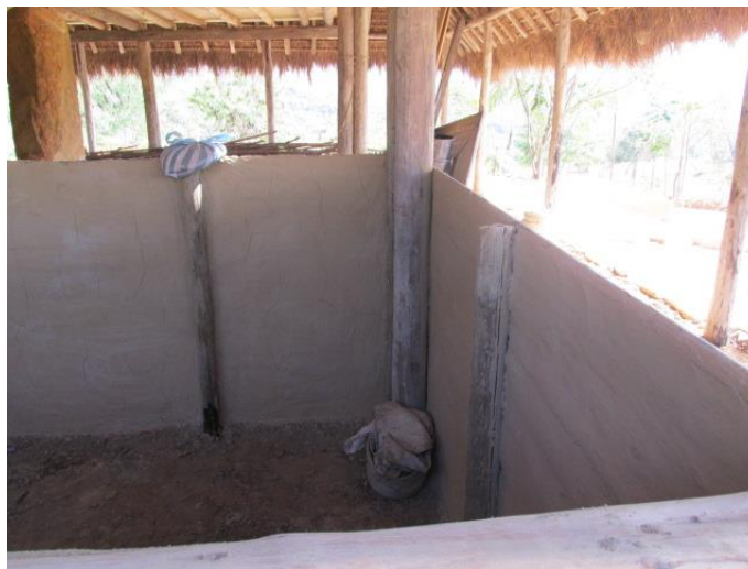
Figura 9. Paredes divisorias en bahareque, Barichara - Santander
