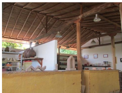
Figura 5. Cubierta de teja de barro y entramado de caña brava, Escuela de Artes y Oficio - Barichara
