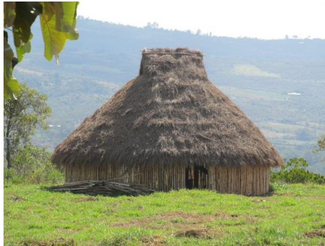
Figura 2. Cubierta en fibras naturales, con soportes y paredes exteriores en guadua . Barichara, Santander. Colombia
